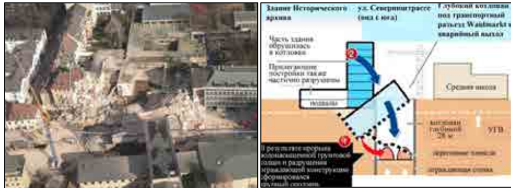
Вид на разрушенное здание архива и наиболее вероятный сценарий разрушения
