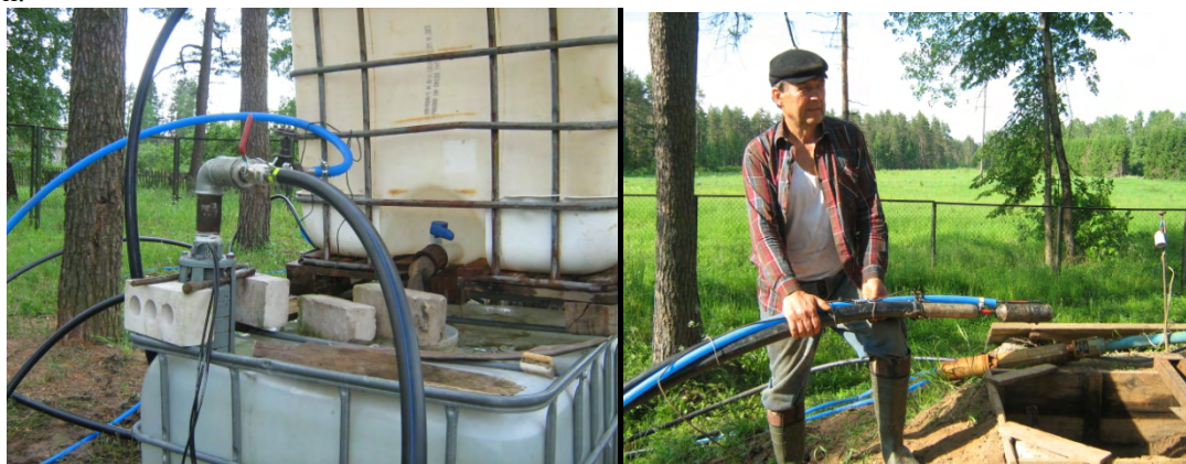
Рис. 2. Наземное оборудование гидроэлеваторной установки на скважине №2/2011 в д. Узла Мядельского района
