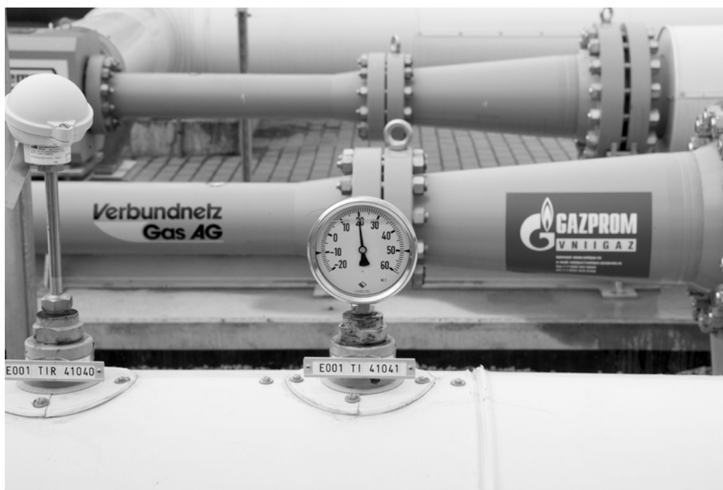
Рис. 1. Газовый эжектор в наземной сети ПХГ
