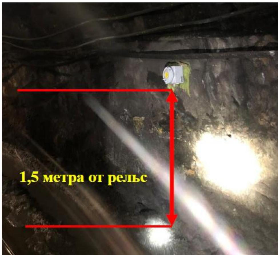
Рисунок 2.3 – Пример правильно установленного сейсмодатчика
