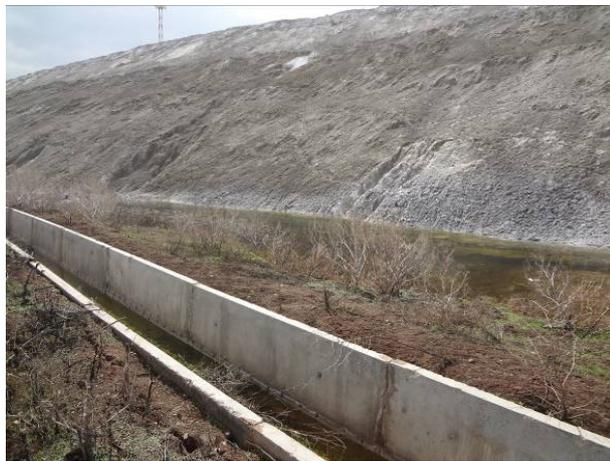
Рисунок 3.29 – Заболачивание территории, прилегающей к нижней бровке отвала
