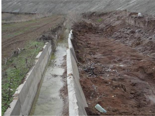
Рисунок 3.28 – Деформации водоотводящих лотков
