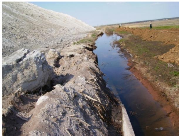
Рисунок 3.30 – Развитие оползней подпошвенного типа с образованием вала выпирания
