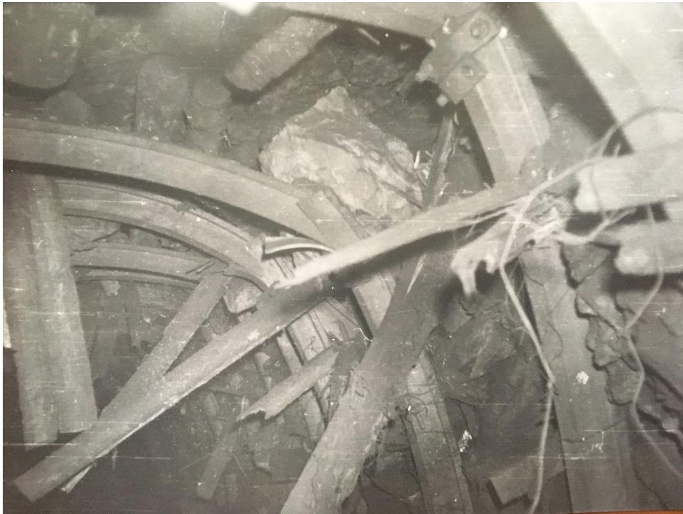
Рисунок 1.5 – Состояние откаточного ярусного штрека в зоне ПГД надрабатываемого пласта
