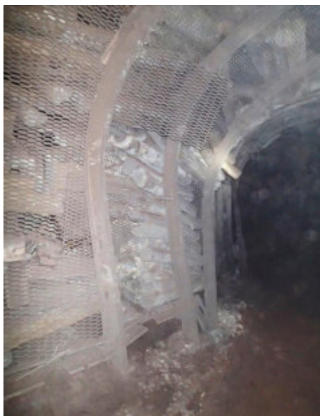
Рисунок 2.22 – Состояние очистной заходки № 4-1-18. Отсутствие на отдельных участках выработки затяжки и забутовки
