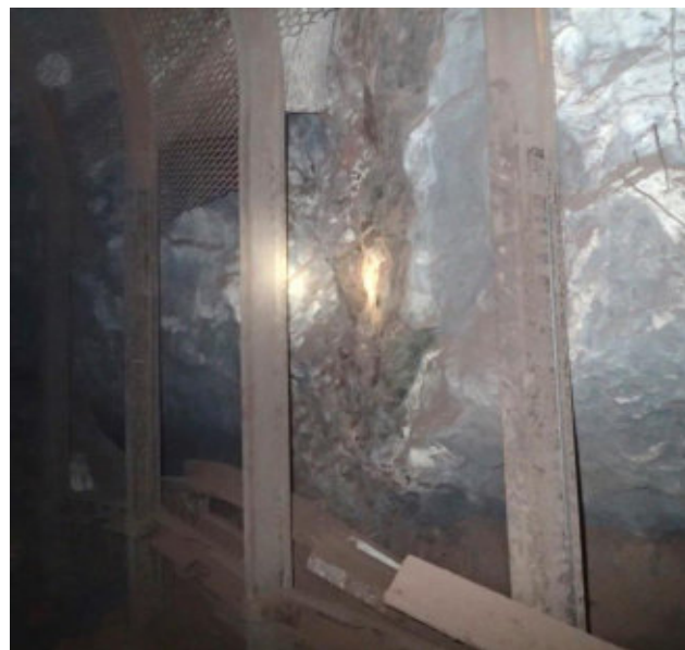
Рисунок 2.22 – Состояние очистной заходки № 4-1-18. Отсутствие на отдельных участках выработки затяжки и забутовки
