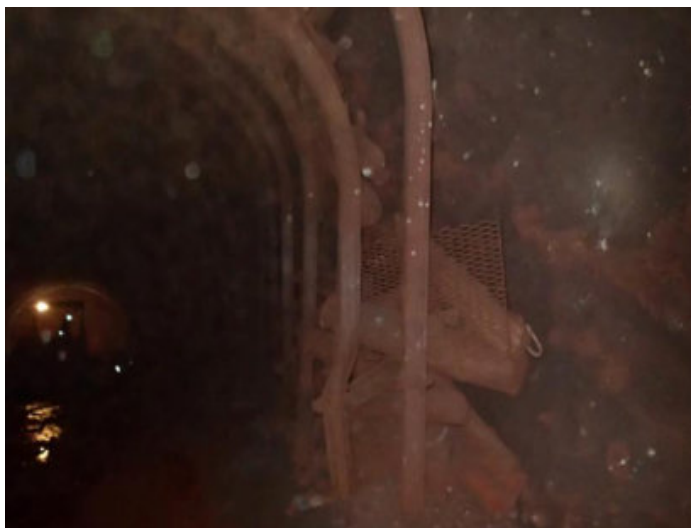
Рисунок 2.19 – Состояние очистной заходки № 6-3-13: а) деформация стойки крепи вследствие вывала; б) отсутствует контакт крепи с массивом порядка 0,4 м
