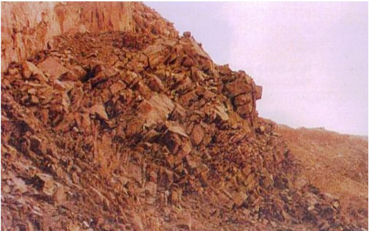
Рисунок 1.6 – Обрушение участка борта карьера в виде опрокидывания слоев [89]
