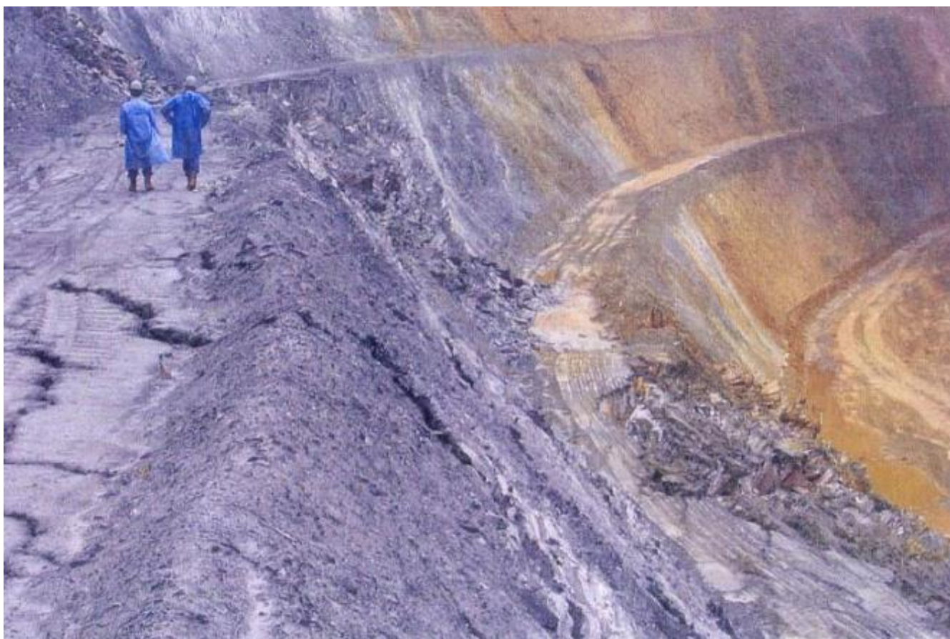
Рисунок 1.7 – Образование трещин в виде «обратных ступенек» [89]
