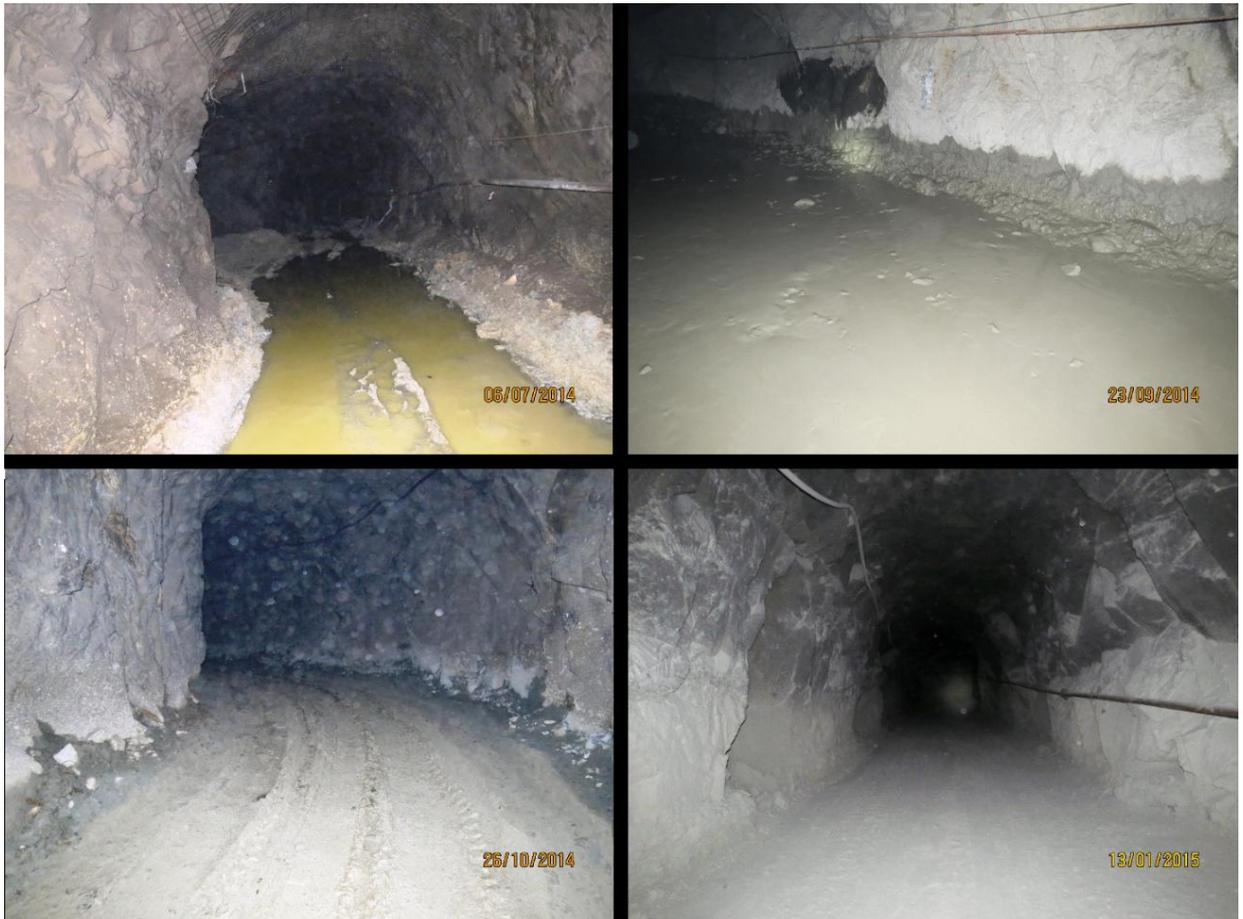
Рисунок 2.1 - Растепление и повторное замерзание горных выработок
