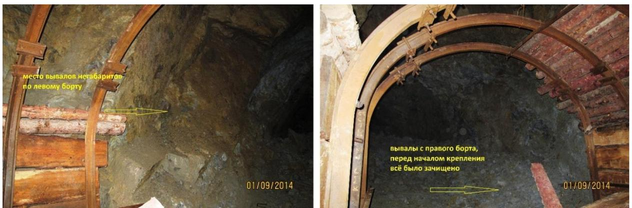
Рисунок 2.3 – Обрушение пород с бортов выработки вследствие таяния мерзлых пород
