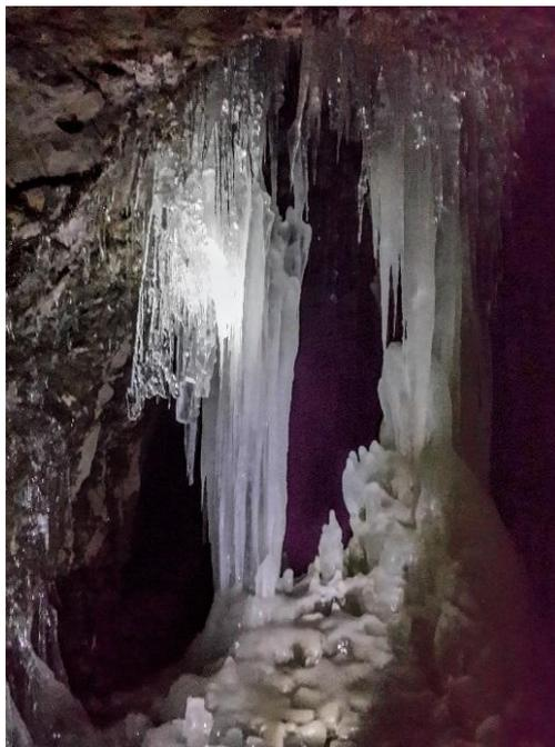
Рисунок 2.2 - Заполнение выработки льдом
