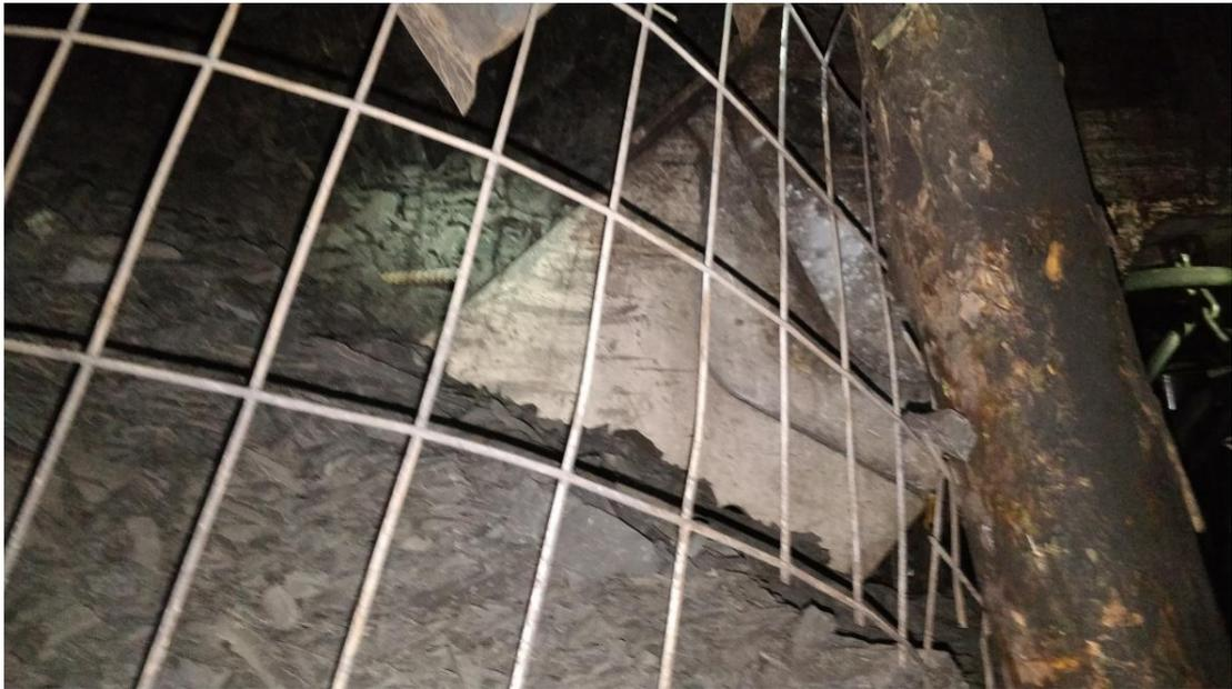
Рисунок 2.15 – Потери устойчивости незакрепленных пролетов кровли
