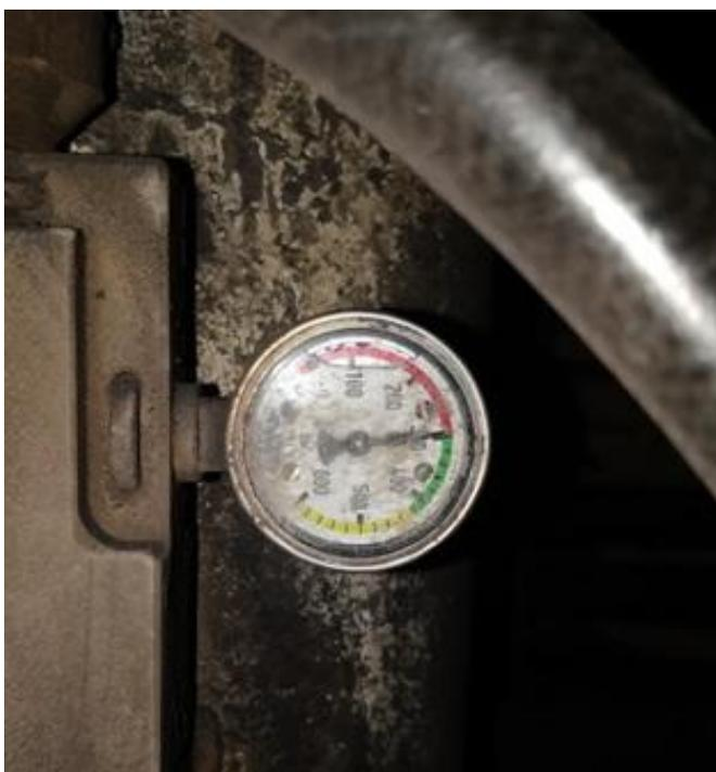
Рисунок 2.14 - Манометр МП-3У установленный на гидростойке
