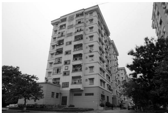
Рисунок 11 – Здание Донгтау N5 Тхиньльет – Хоангмай, г. Ханой
