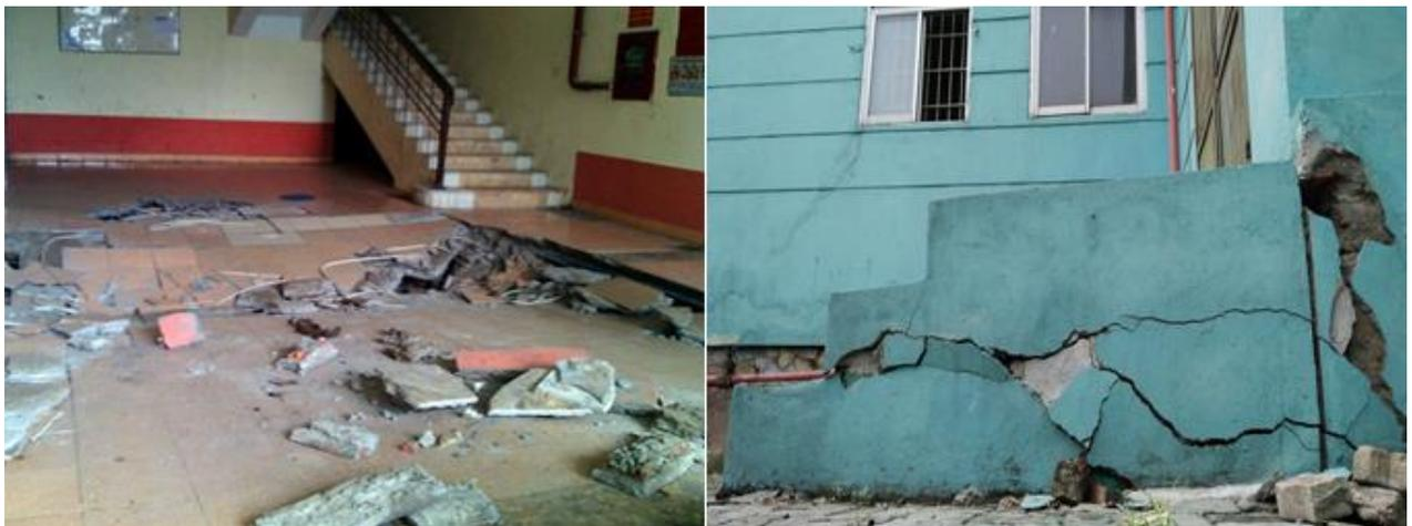
Рисунок 4.3 – Обвал и осадки здания Донгтау *N5* (<https://baomoi.com/can-canh-chung-cu-n5-dong-tau-sut-lun-nguy-hiem-chet-nguoi/c/20097930.epi>)
