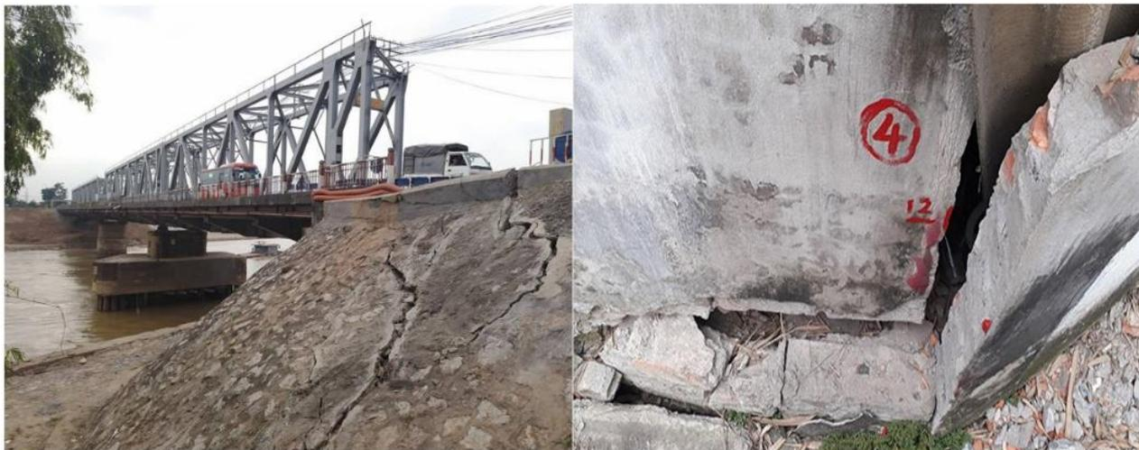
Рисунок 4.7 – Оседание при устои моста Дуонг и жилого комплекса
