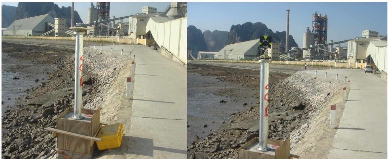
Рисунок 1.18 – Трубчатая деформационная марка для определения смещений сооружений на цементном заводе Камфа (Вьетнам)
