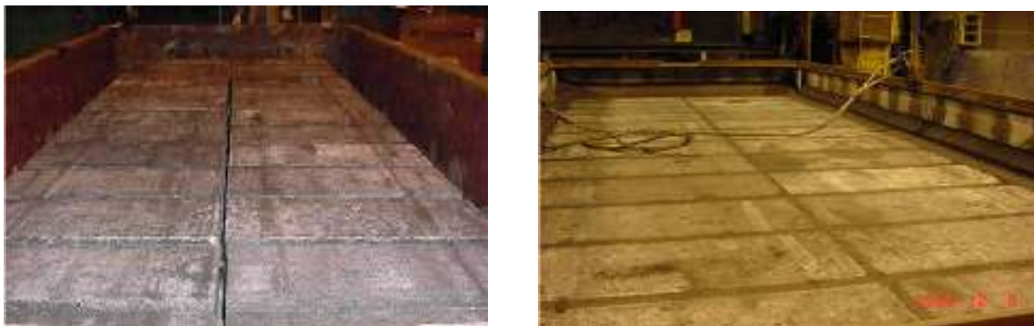
Рисунок 1.72 – Стадия монтажа до и после набойки швов
