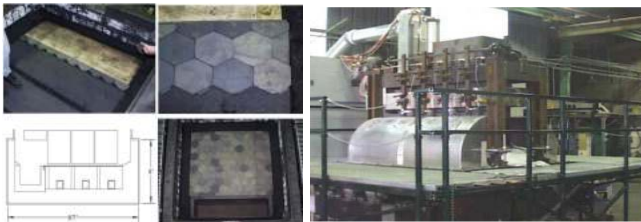
Монтаж катодных плиток
