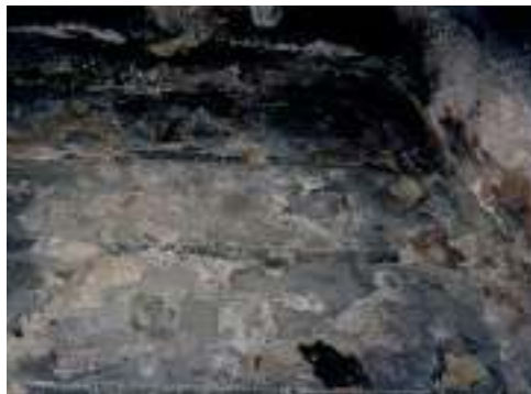
Рисунок 1.24 – Вид подины 1-го электролизера после периода работы 21 сутки
