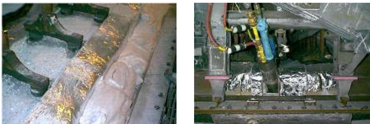
Рисунок 1.73 – Электролизёр на газовом обжиге с установленными газовыми горелками.
