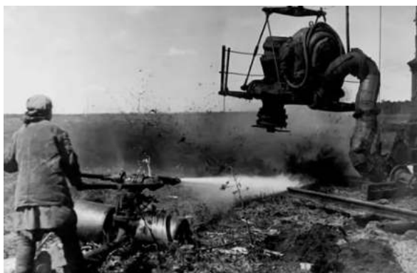
Рисунок 1.6 – Гидравлический способ добычи торфа
