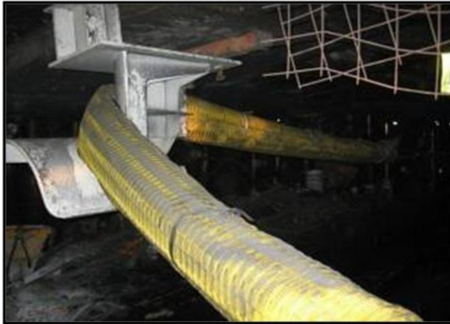
Рисунок 4.13 – Монтажная направляющая
