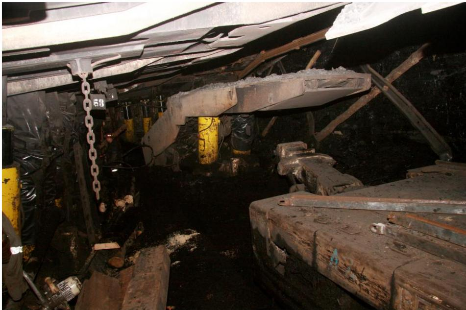
Рисунок 4.22 – демонтаж секции крепи тягачом Petitto Mule
