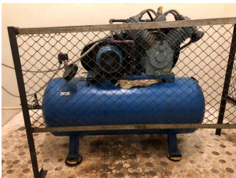
Рисунок 33 - Компрессорная установка С416М
