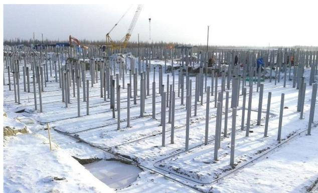
Рисунок 22 - Системы ВЕТ в основании технологической обвязки трубопроводов ДКС на Заполярном НГКМ [42]
