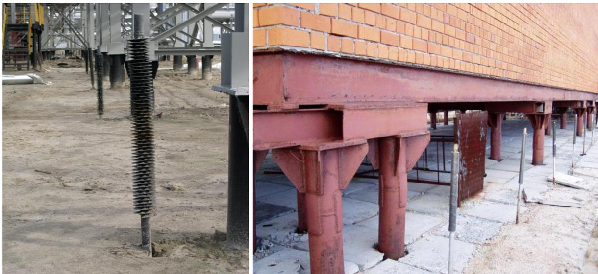
Рисунок 8 – Применение СОУ на объектах проектирования ПАО «ВНИПИГаздобыча» [18]
