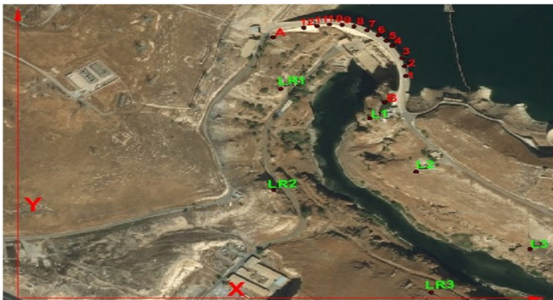
Рисунок 2.1– Общий вид плотины «Дукан».
