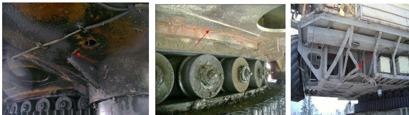
Рисунок 1.5 – Трещина в ходовом механизме экскаватора ЭКГ-10
