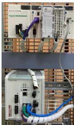
Рисунок 4.26 – Контроллер M340: а – общий вид; б – порты и каналы подключения: 1 – процессорные модули VMXP34; 2 – платформа ввода/вывода Modicon X80 с одним или несколькими шасси; 3 – дополнительные и специализированные модули
