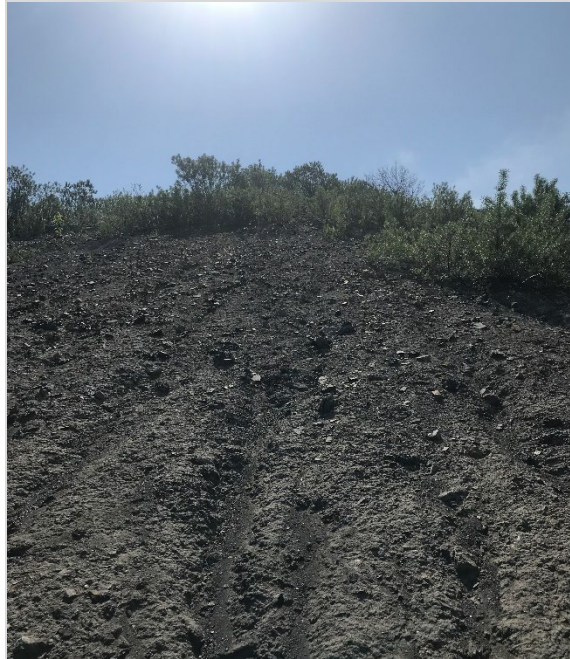
Рисунок 2.4 – Пример эффекта эрозии, вызванного стоком дождевой воды на откосе отвала «Южный»
