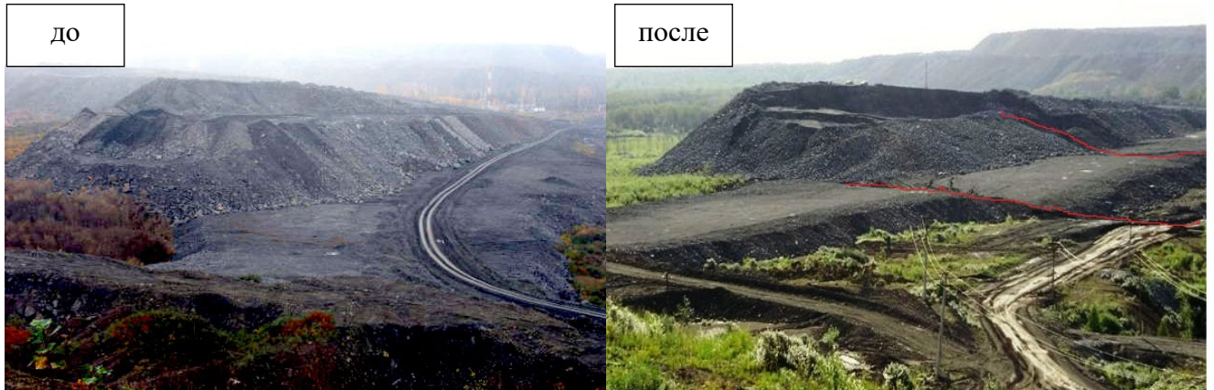
Рисунок 4.6 – Положение отвала до и после развития оползневой деформации оползня
