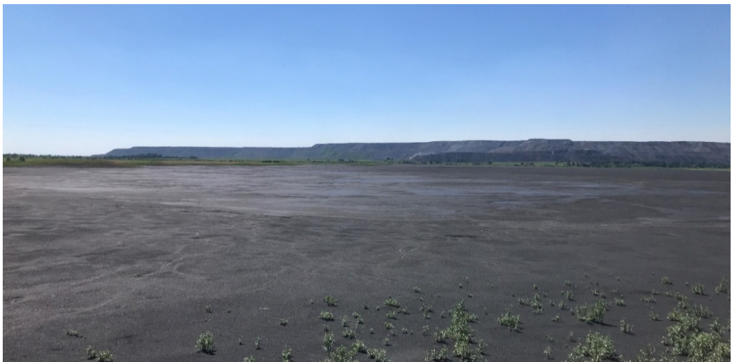
Рисунок 3.15 – Фото гидроотвала «Бековский». Вид на намытый пляж 08.06.2021г.
