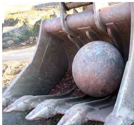
Рисунок 1.7 – Сбрасывание шар-бабы с ковша экскаватора
