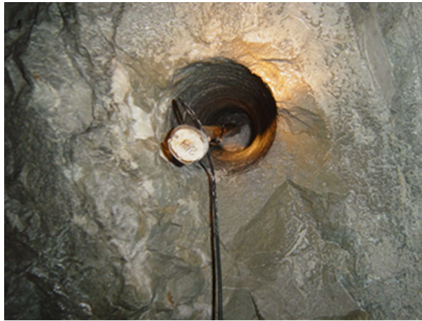
Рисунок 4.2 – Измерительная скважина с установленным в нее акселерометром
