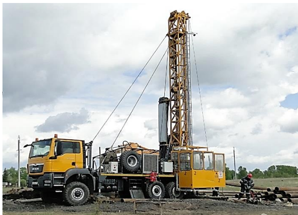
Рисунок 4.2 — Буровая установка Prakla RB-50
