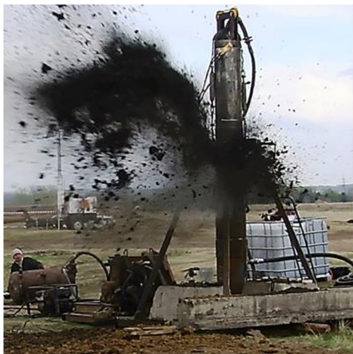
Рисунок 4.15 — Процесс погружения трубы и выхода породы
