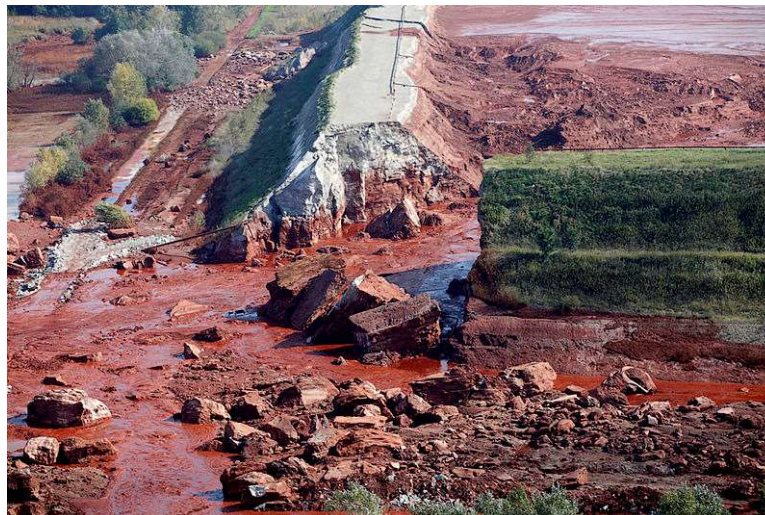
Рисунок 1.2 - Прорыв дамбы в Венгрии [11]
