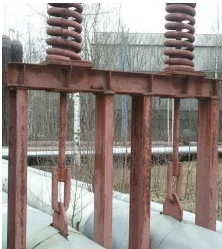
Рисунок 3.1 – Подвесная опора трубопроводов [142]
