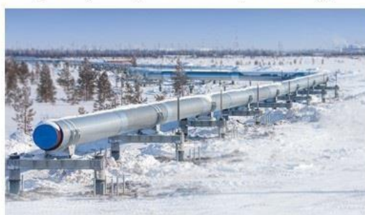
Нефтепровод «Заполярье – Пурпе»
