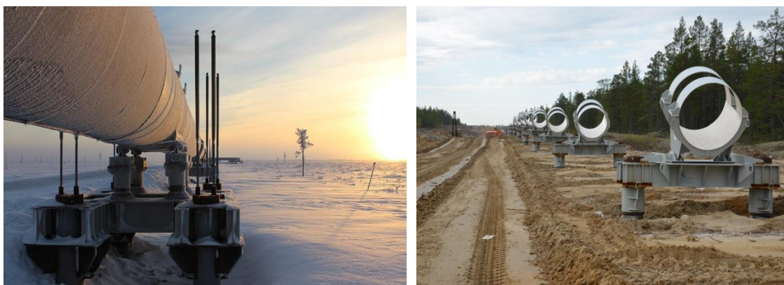
Рисунок 1.6 – Опоры неподвижная и продольно-подвижная [101]
