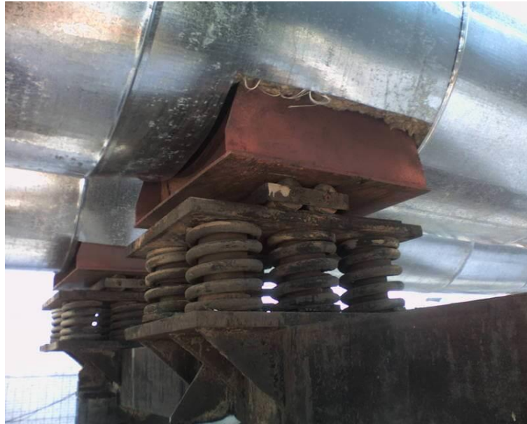
Рисунок 3.10 – Трубопровод на опорах с пружинами [143]
