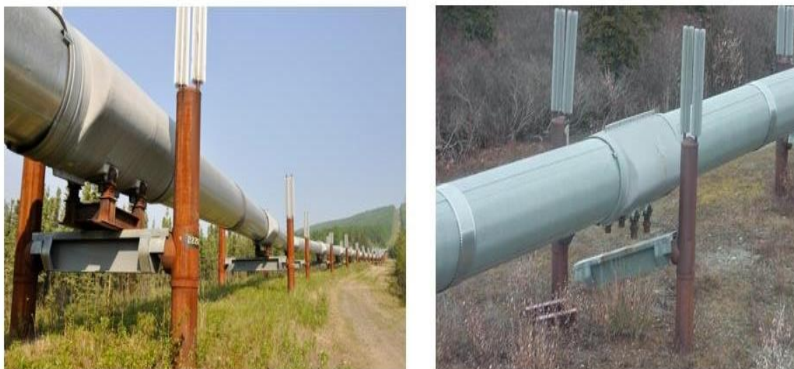
Рисунок 1.7 – Трубопроводы на опорах в северных районах [101]
