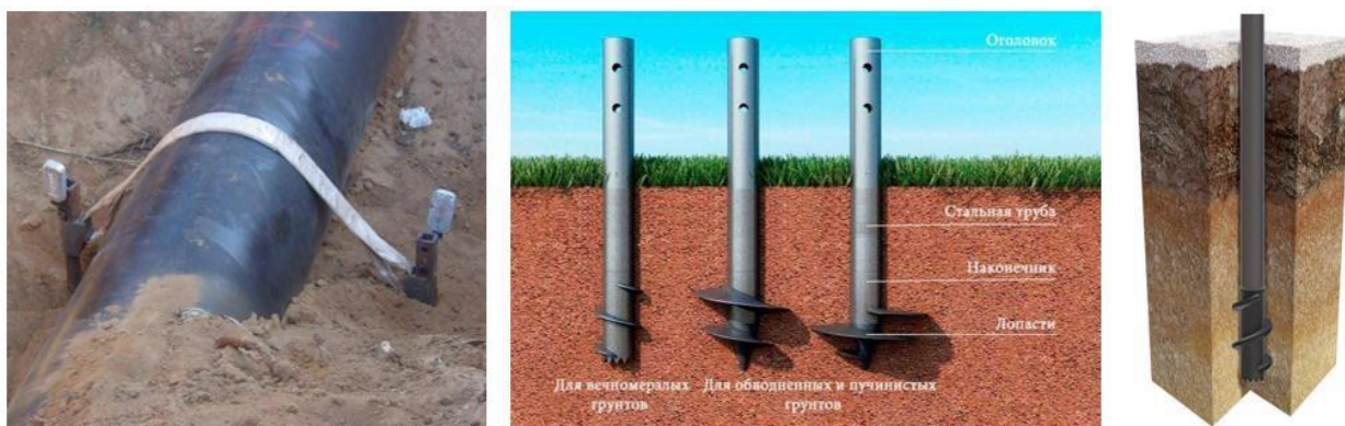
Рисунок 3.2 – Закрепление трубопроводов анкерными устройствами [142]
