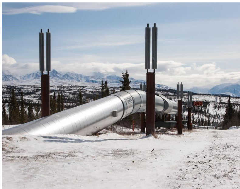
Рисунок 3.5 – Трубопровод на сваях [142]
