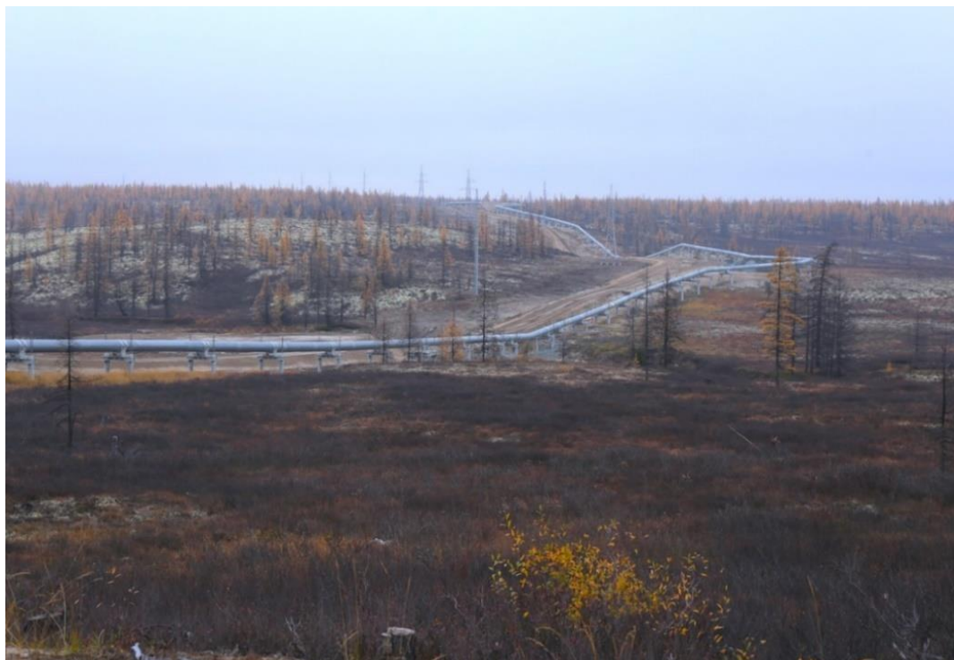
Рисунок 1.8 – Прокладка трубопровода на сваях в многолетнемерзлых грунтах «Заполярье-Пурпе» [101]
