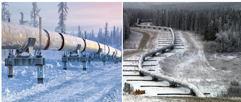
Рисунок 1.4 – Опоры трансаяскинского трубопровода [101]
