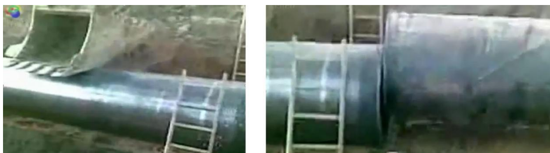
Рисунок 1.2 – Смещение концов трубопровода после его разрезания при прижатии трубопровода ковшем экскаватора [142]
