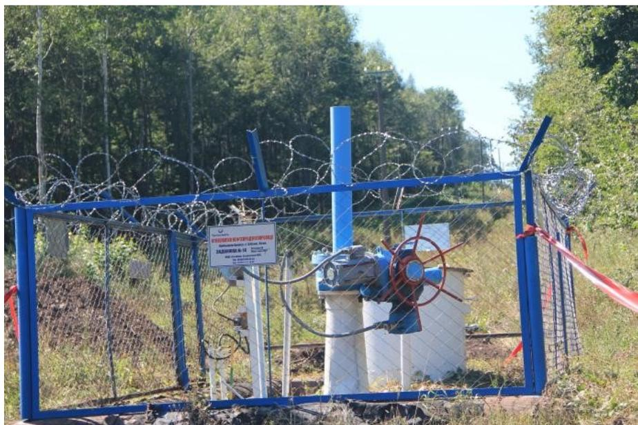
Рисунок 1.21 – ПТМ с запорной арматурой с приводным устройством на подземной нефтепроводе
