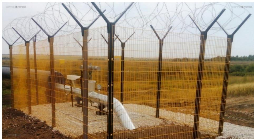
Рисунок 1.20 – ПТМ для запуска и приема средств очистки и диагностики на надземном нефтепроводе
