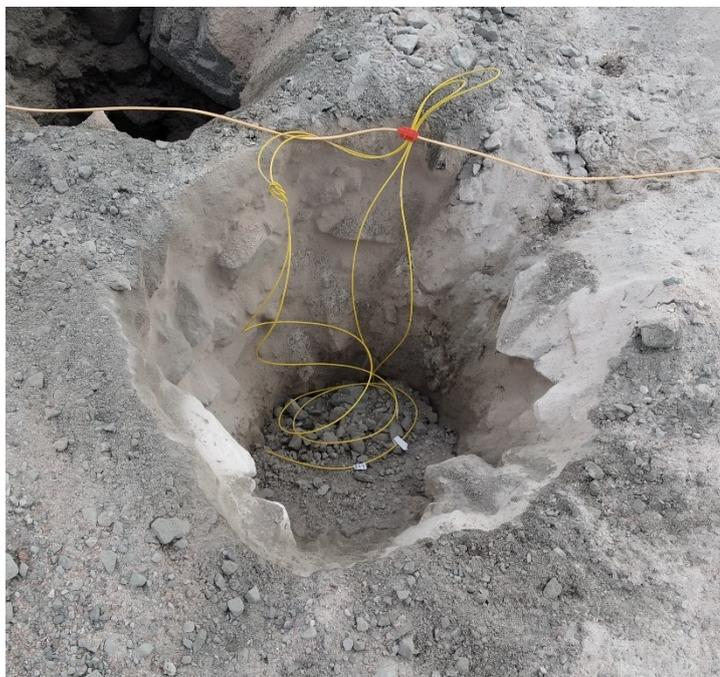
Рисунок 1.10 – Сквaziна на взрываеом блоке
