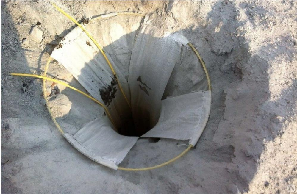
Рисунок 4.5 – Гидроампула для гидрозабойки
