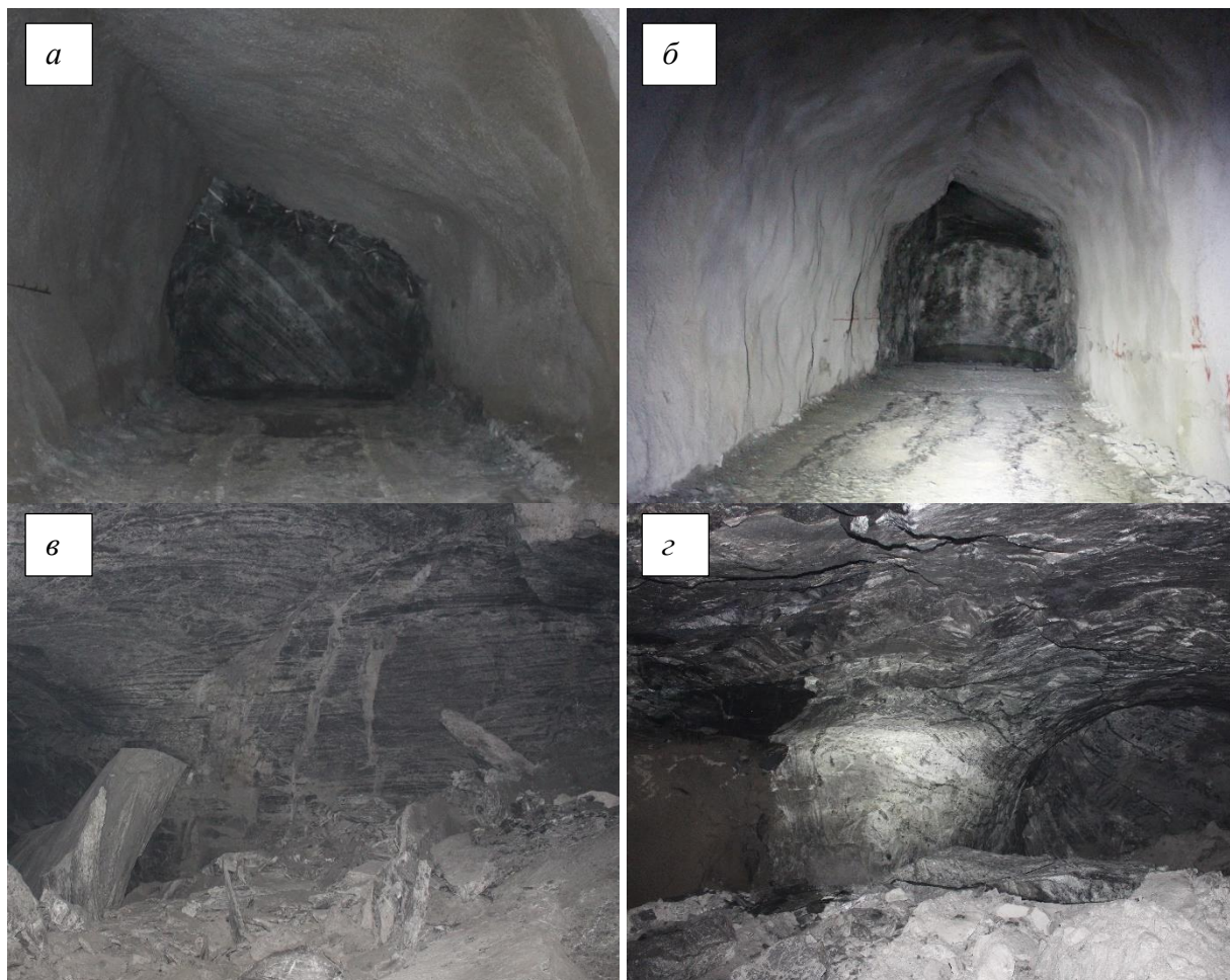
Рисунок Д.1 - Примеры зон хрупкого разрушения породного массива в окрестности горных выработок: а, б – одиночные выработки; в, г – сопряжение горных выработок
