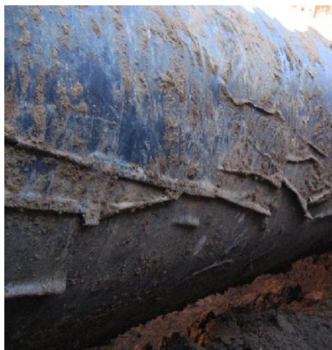
Рисунок 1.7 – Гофры на изоляционном покрытии магистрального трубопровода [43]
