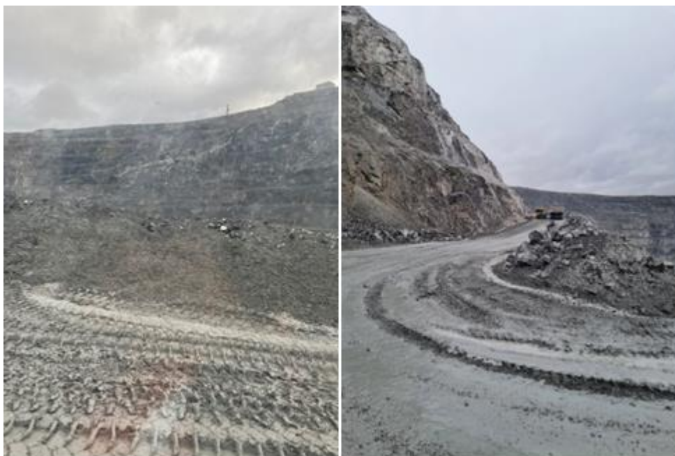
Рисунок 2.4 – Неудовлетворительное качество дорожного слоя участка технологической трассы транспортирования на Ковдорском ГОКе (фото автора)
