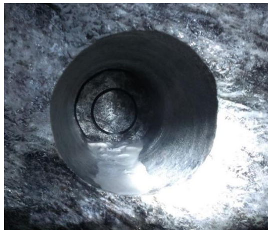
Рисунок 2.4 – Бурение измерительной скважины
