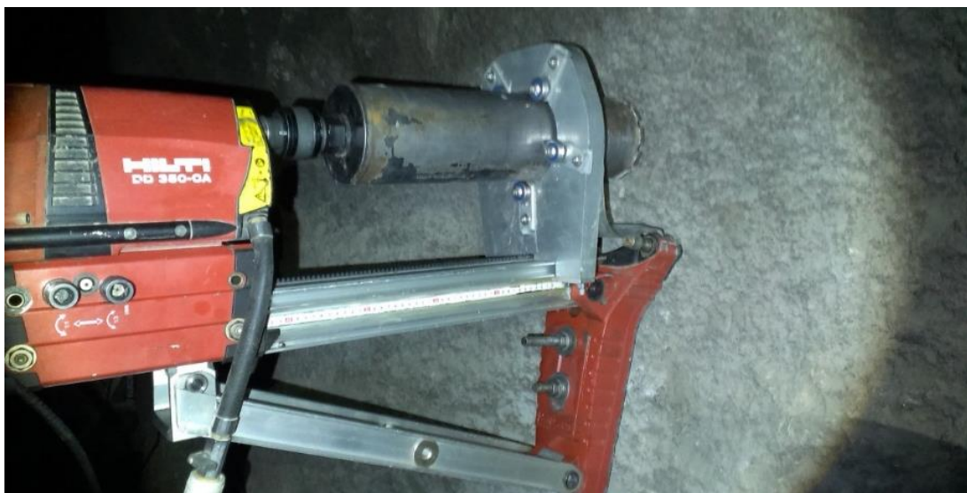
Рисунок 2.3 – Установка бурового оборудования
