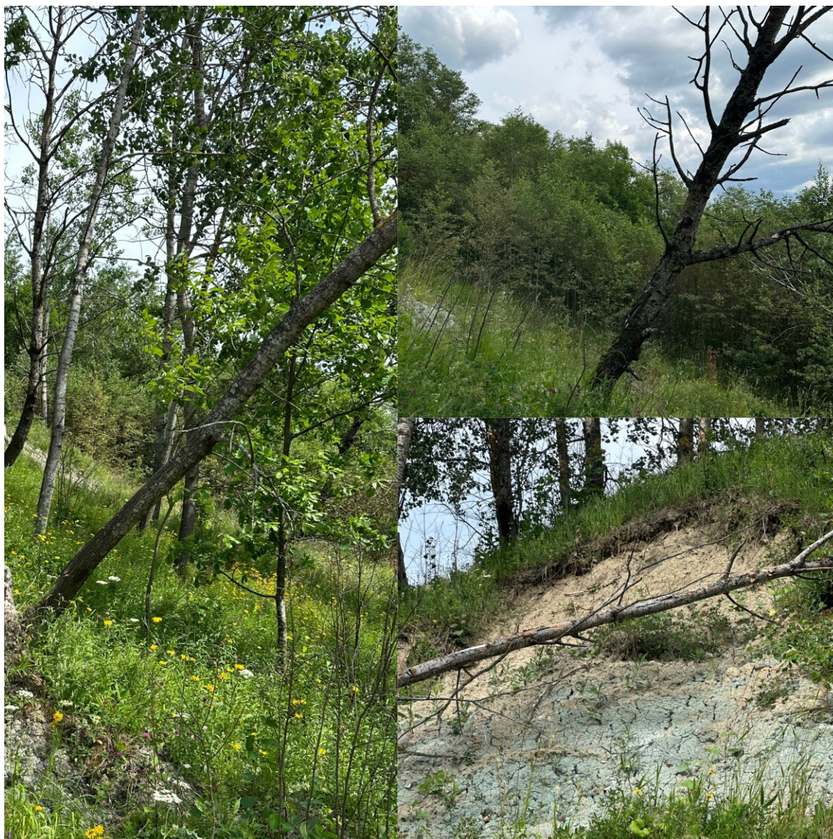
Рисунок 29 – Покосившиеся вследствие оползневых процессов деревья на склоне
