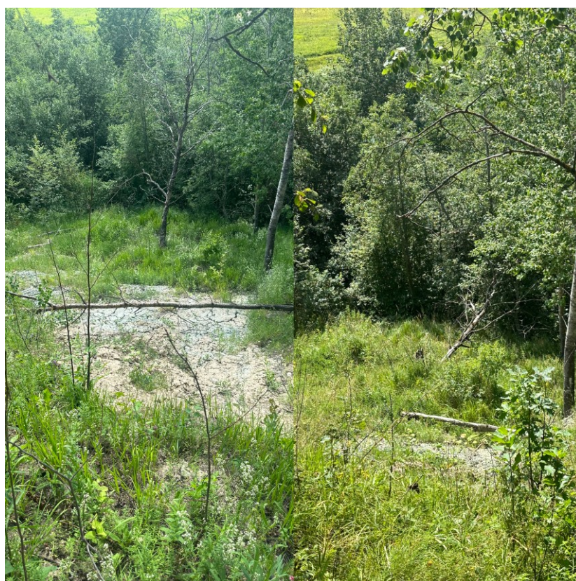
Рисунок 34 – Деформации оползневого склона левого берега реки Тосны, обнаруженные в ходе визуального осмотра (слева – этап 0 цикла наблюдений (15.07.2023 г.), справа – этап 3 цикла наблюдений (28.07.2024 г.))
