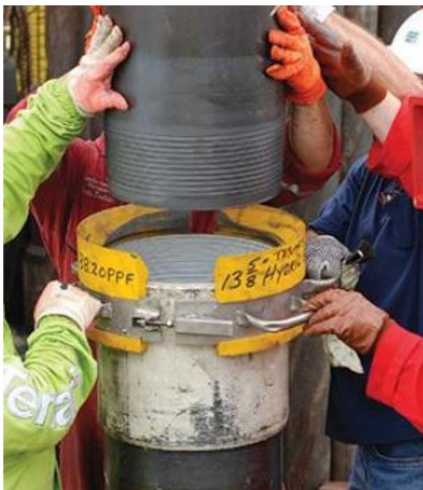
Рисунок 1.1 – Резьбовое соединение бурильных труб
