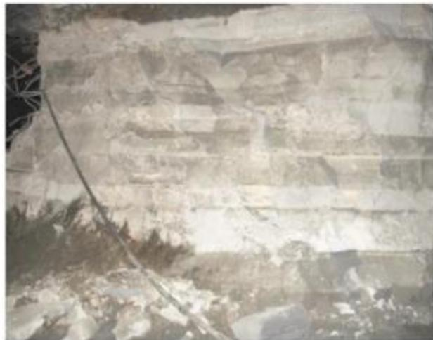
Рисунок 4.7 - Слоистая структура закладочного массива в борте очистной камеры
