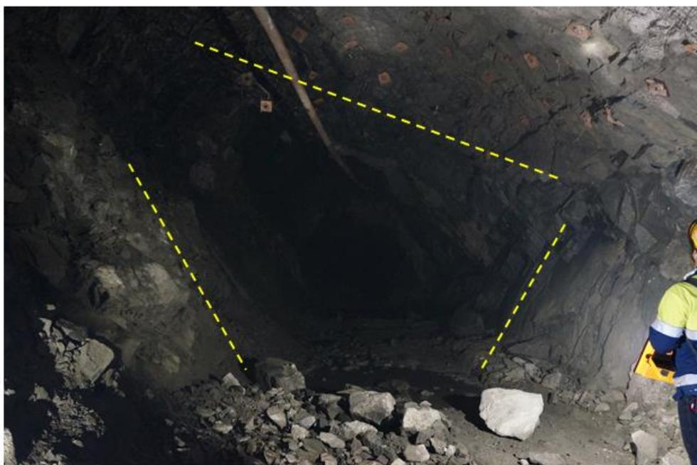
Рисунок 2.1 - Обрушение западного борта нарезной выработки.
