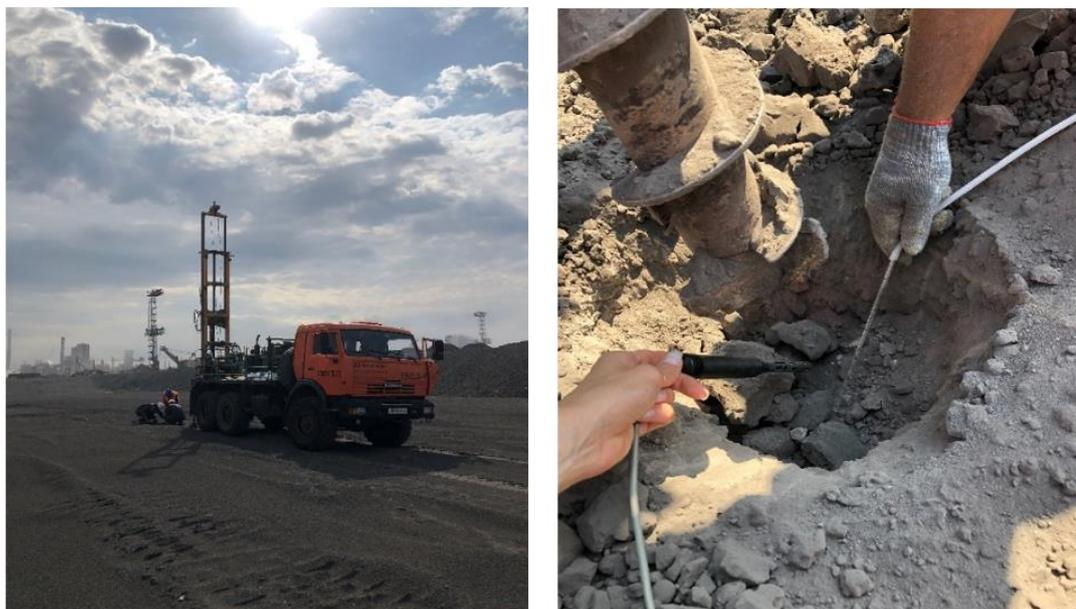
Рисунок 2.6 – Проведение буровых работ и замеров отходящей газовой смеси
