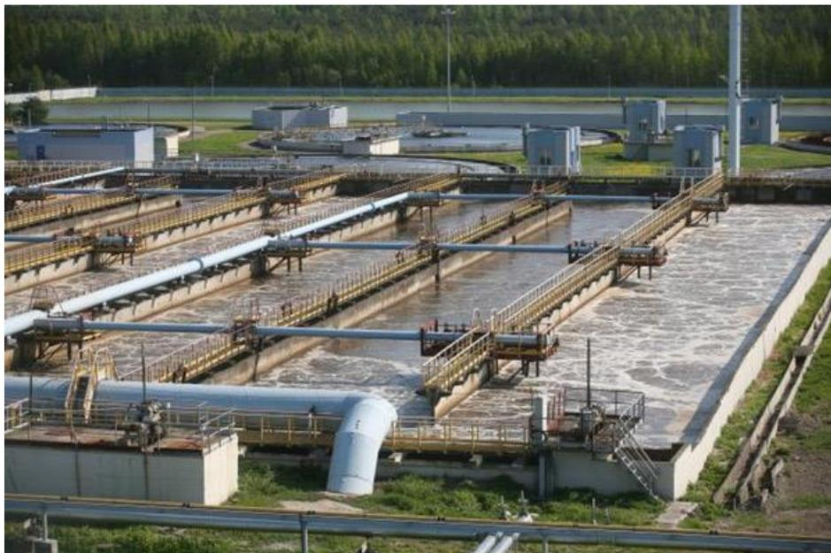
Рисунок 3.9 – Открытый аэротенк для биологической очистки сточных вод
