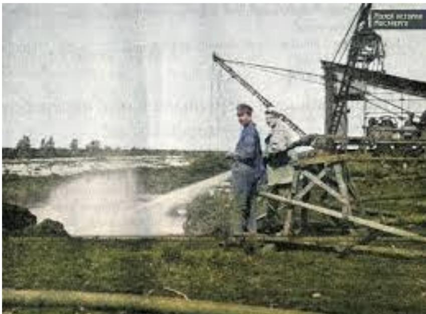
Рисунок 1.12 – Получение гидроторфа размывом [71]
