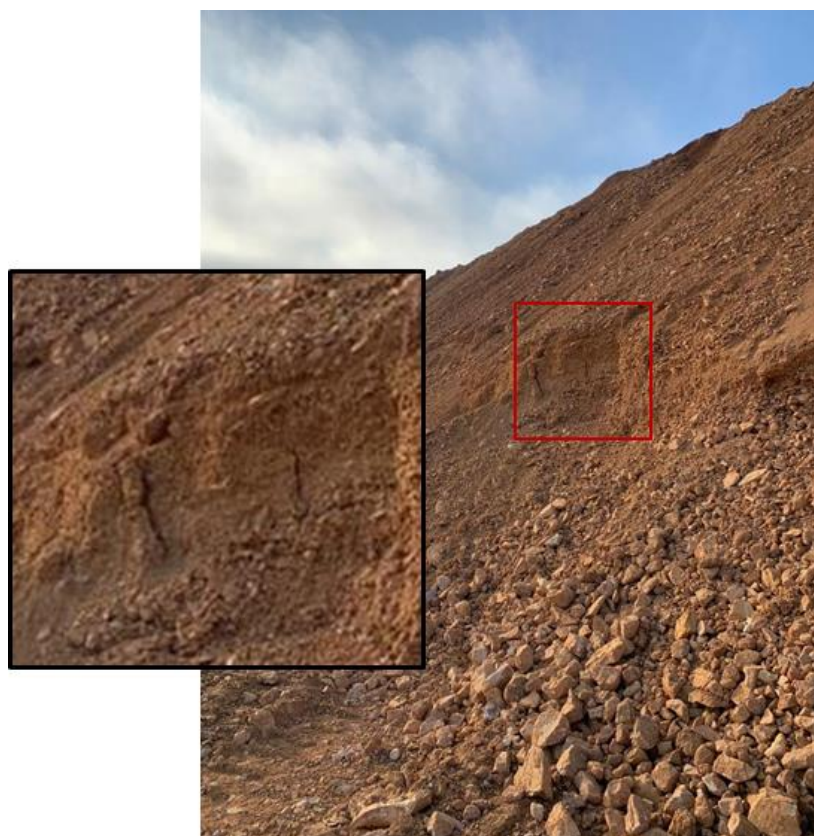
Рисунок 4.5– Откосная поверхность рудного штабеля КВ, сложенная мелкой фракцией
