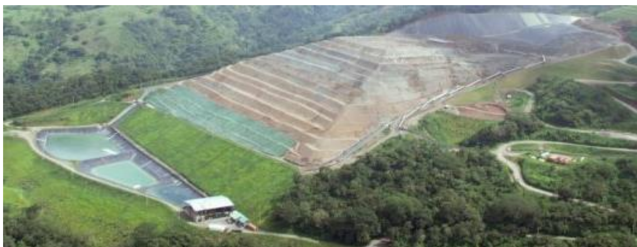
Рисунок 1.4 – Общий вид штабеля прощадки КВ золота рудника Bellavista, Коста-Рика [145]
