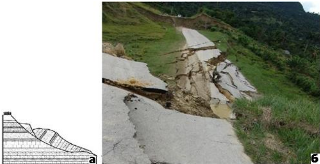
Рисунок 2.14 – Оползни скольжения вращательные в местности Белтран: а) схема оползня [146]. б) фотография оползня, развившегося на формации Макей (фото из архивов горного центра Нипе-Сагуа-Баракоа, Куба)
