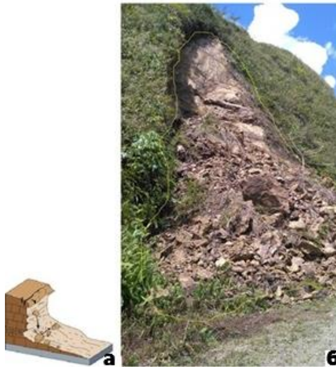
Рисунок 2.16 – Обвал: а) схема оползня [146]; б) фотография оползня (фото автора)
