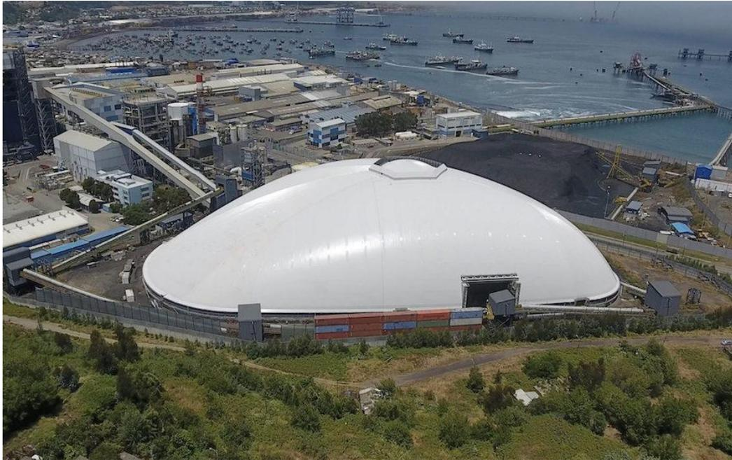
Рисунок 1.1.6 - Купольный склад угля закрытого типа теплоэлектростанции Бокамина в Чили [82]
