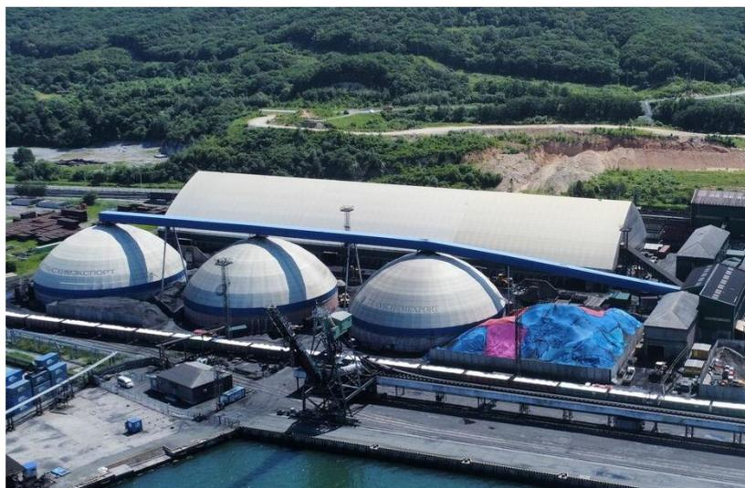
Рисунок 1.1.3 - Восточно-Уральский терминал с закрытым складом и тремя купольными складами [11]
