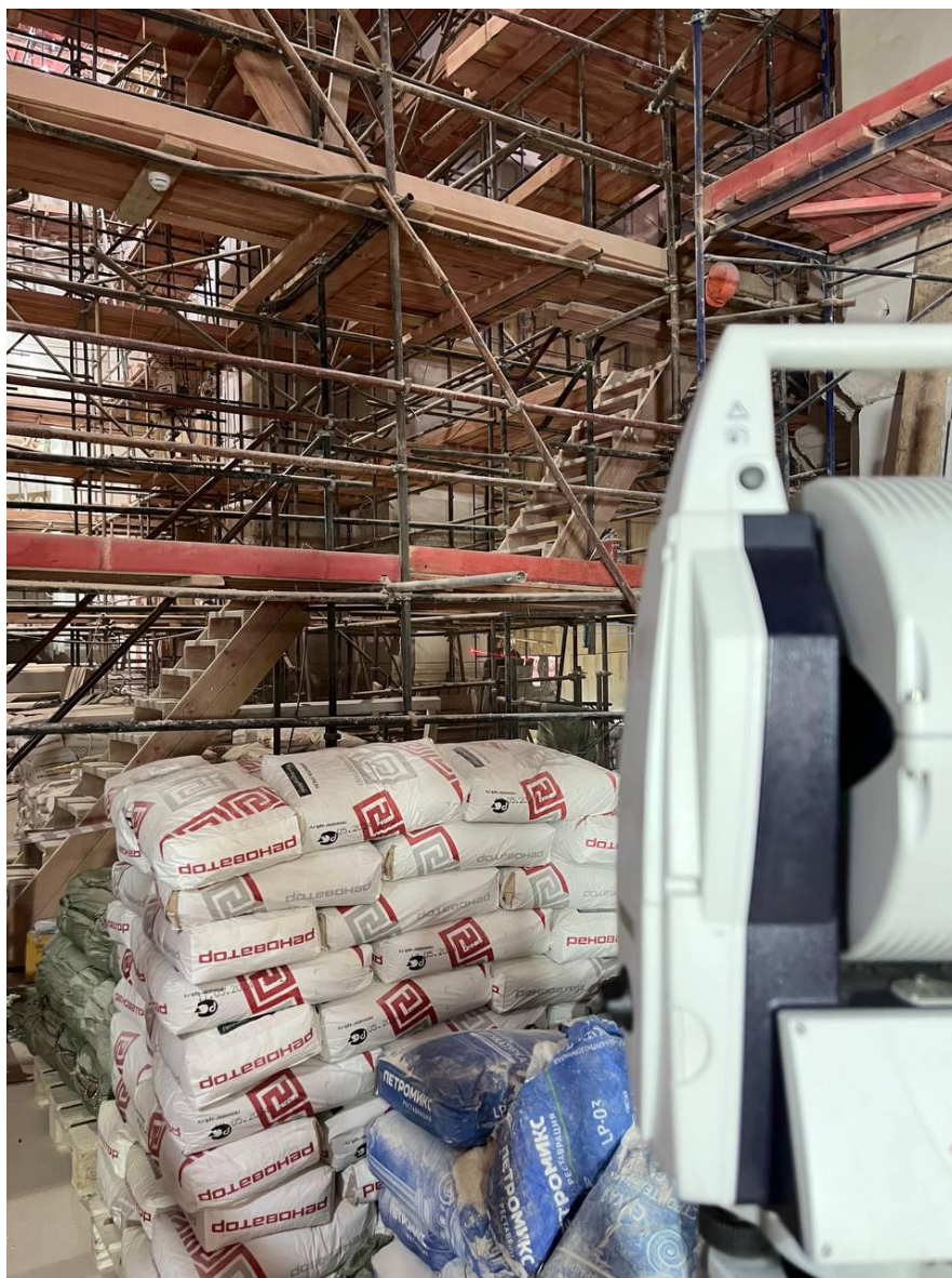
Рисунок 1.9 – Использование лазерного трекера в условиях реконструкции здания (фото автора)
