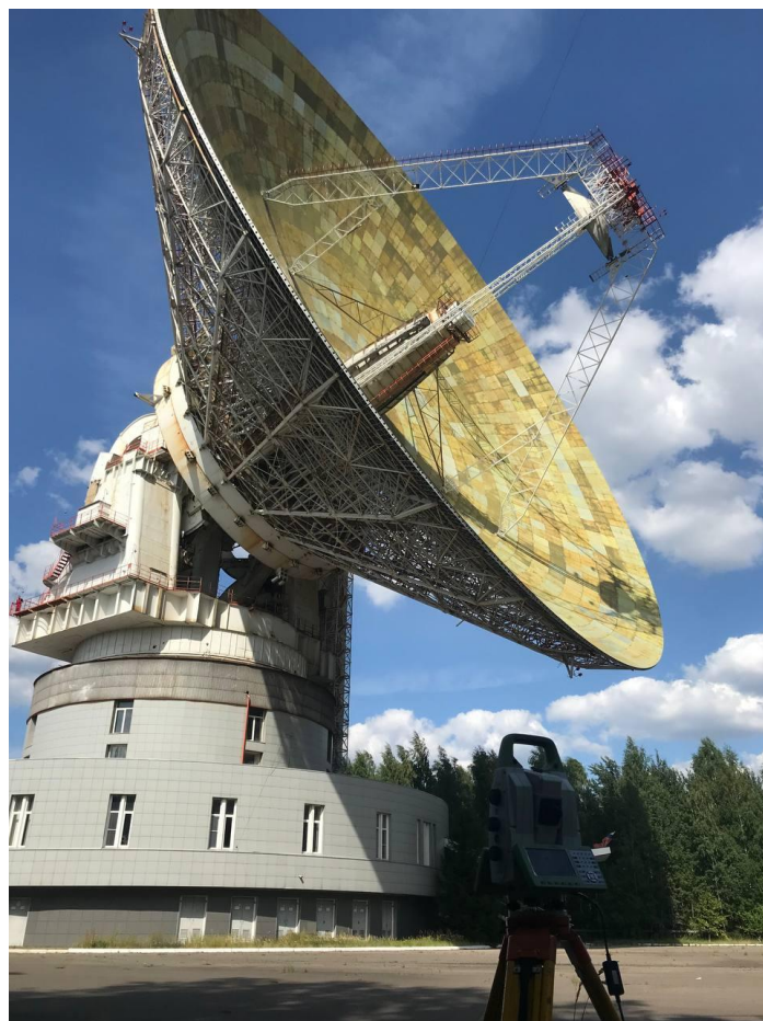
Рисунок 1.8 – Мониторинг состояния радиотелескопа с применением роботизированного тахеометра (фото автора)
