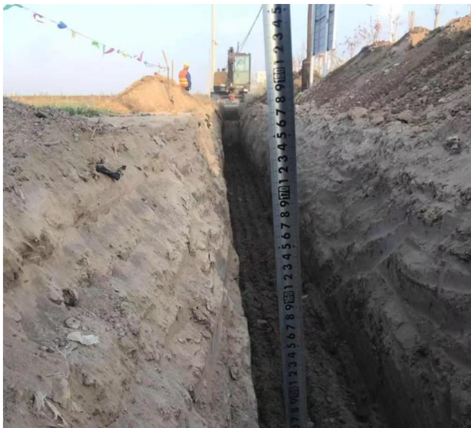
Рисунок 3.7 – Подготовка траншеи под газопровод, глубина 1,7 м (фото автора)
