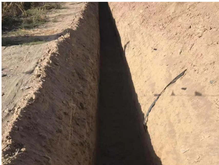
Рисунок 3.6 – Подготовка траншеи под газопровод (фото автора)
