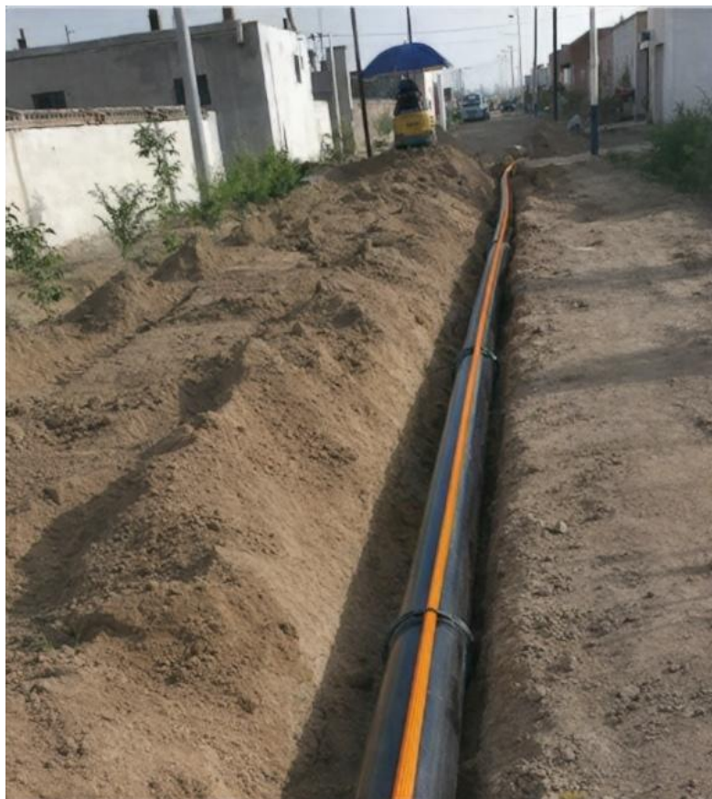
Рисунок 3.11 – Укладка газопровода с волоконным кабелем (фото автора)
