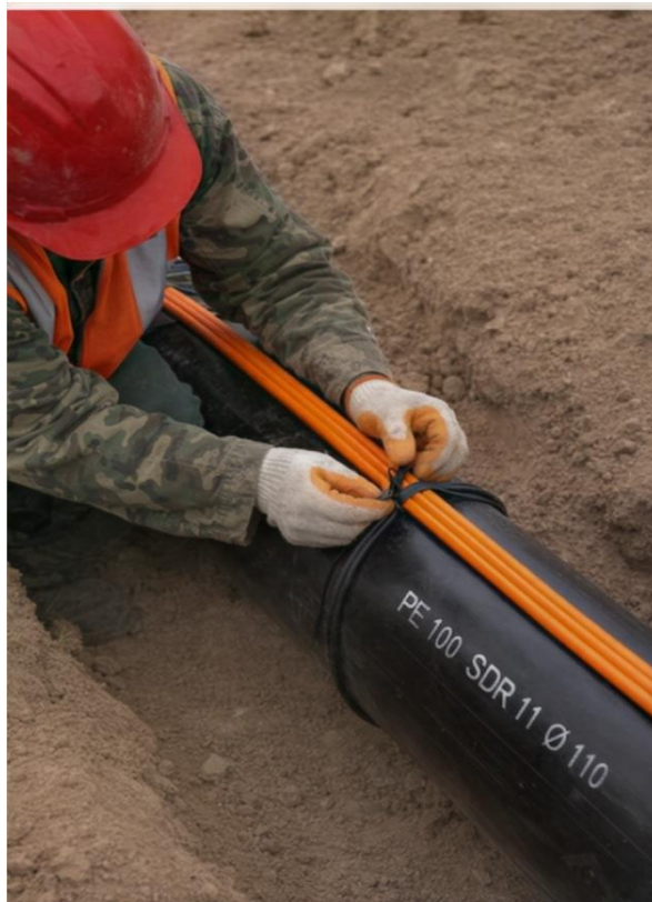
Рисунок 3.10 – Закрепление волоконного кабеля на газопроводе (фото автора)
