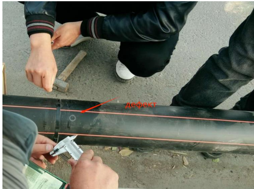
Рисунок 3.9 – Фрагмент подготовки экспериментального участка с моделируемым дефектом на полиэтиленовой трубе (фото автора)
