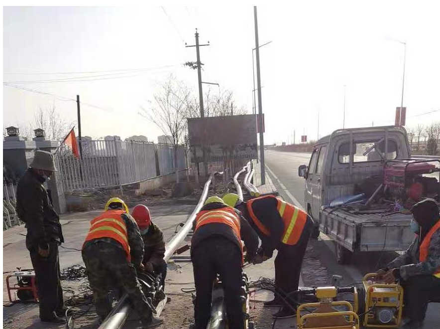
Рисунок 3.8 – Выполнение стыковой сварки полиэтиленового газопровода в полевых условиях (фото автора)
