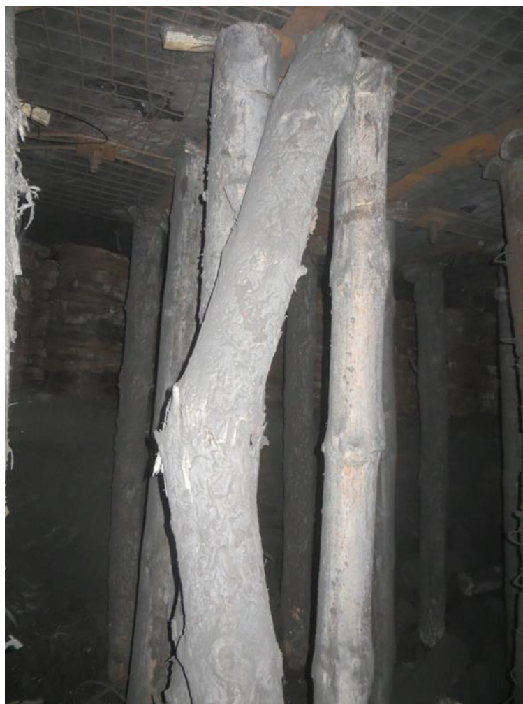
Рисунок 1.6 – Излом рудничных стоек на границе с выработанным пространством (фото автора)
