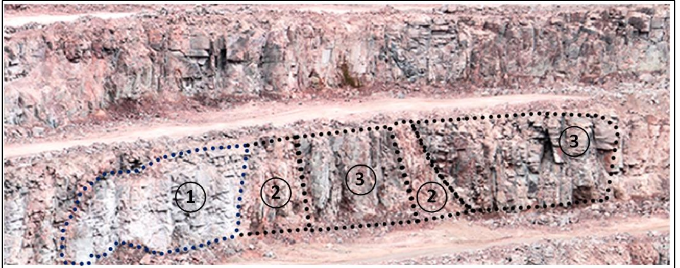
Рисунок 4.2 -Типовой откос взрываемого блока со сложноструктурным строением массива:
