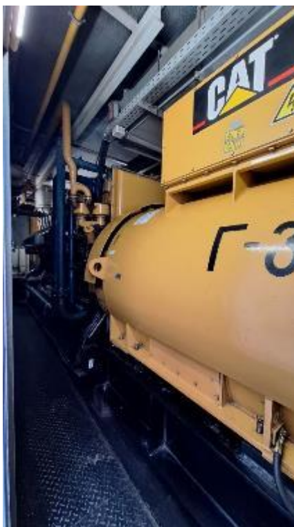
Рисунок 5.1 – Общий вид ГПЭА Caterpillar G3520C (составлено автором)
