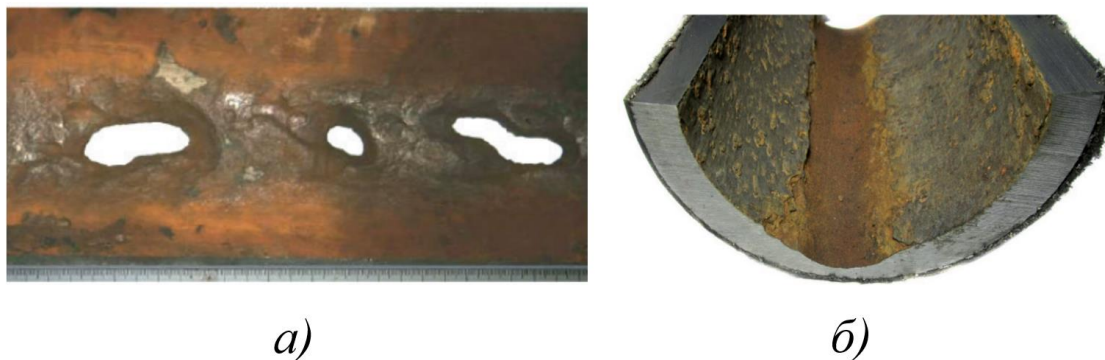
Рисунок 1.5 – Дефекты, образованные в результате слияния коррозионных язв на внутренней поверхности стенки трубы (а – дефекты сложной формы , б – протяженная канавка [55])
