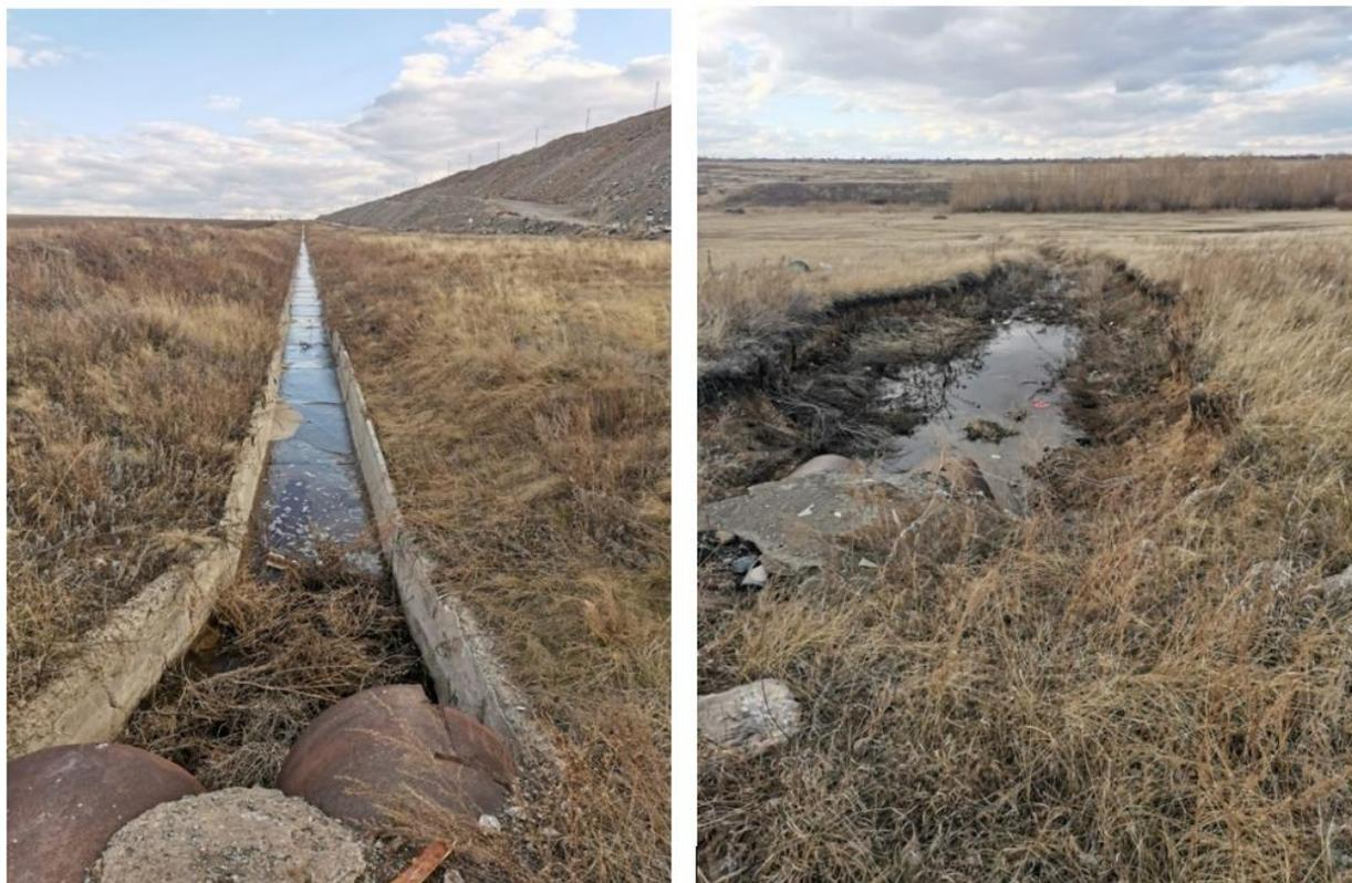
Рисунок 1.13 – Водоотлив талых и дождевых вод хвостохранилища
