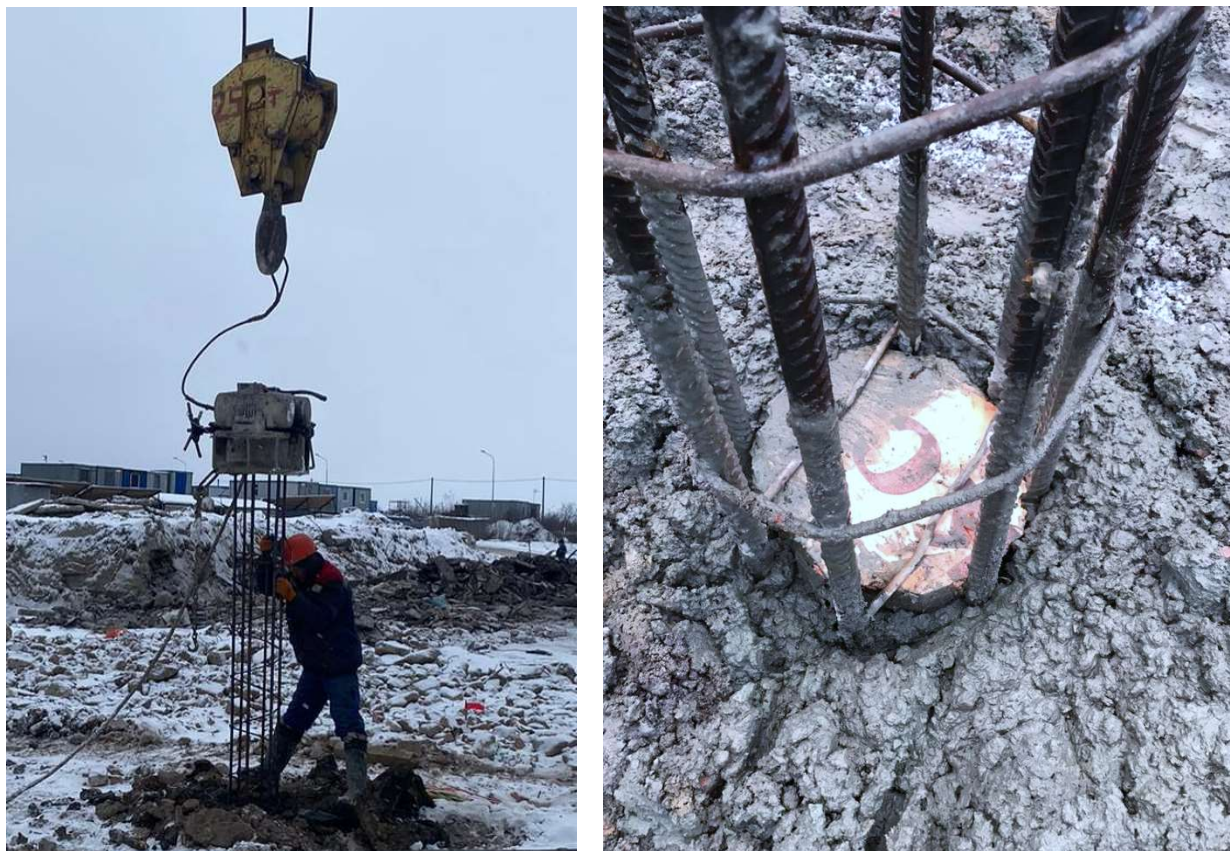
Рисунок 3.7 – Армирование скважины арматурными каркасами с искусственными дефектами
