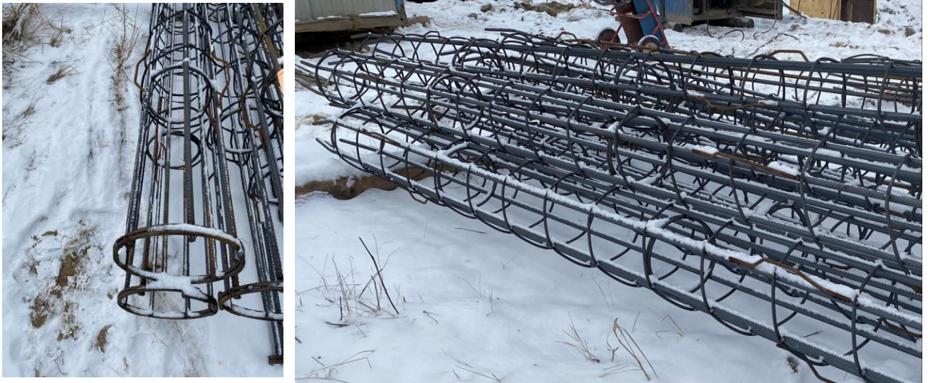
Рисунок 3.4 – Готовые арматурные каркасы
