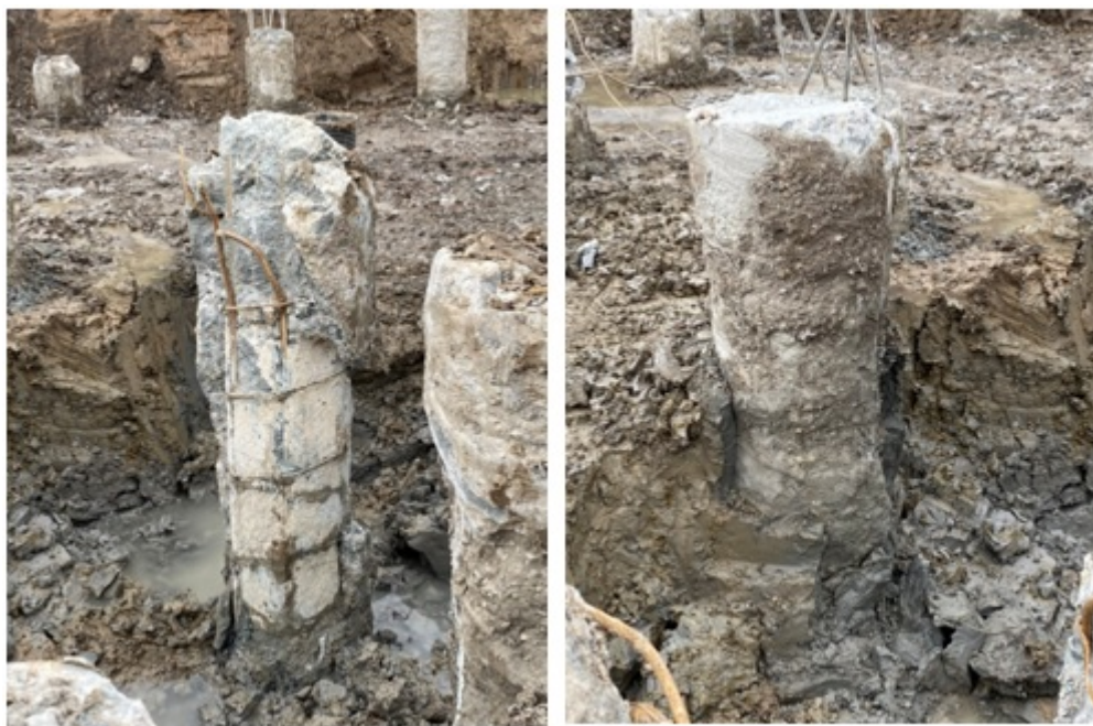
Рисунок 1.6 – Дефект в свае, изготавливаемой в грунте, «утонышение»
