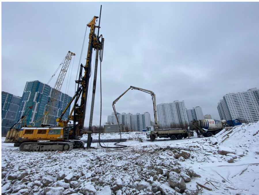
Рисунок 3.6 – Процесс бетонирования испытательного образца (свай)
