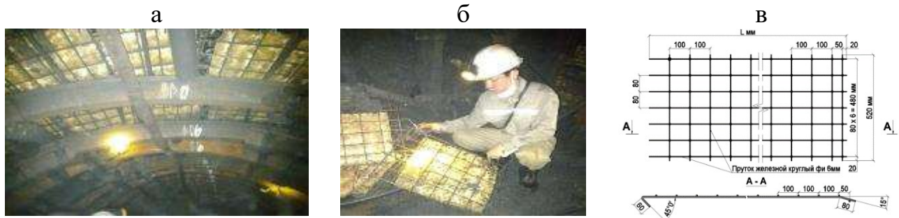
Рисунок 2.11 – Затяжка, применяемая при проходке подготовительных выработок по угольям с низкими прочностными характеристиками (пласт 14–5, шахта «Хечам») [18]: а – общий вид кровли выработки; б – затяжка; в – металлическая решетка
