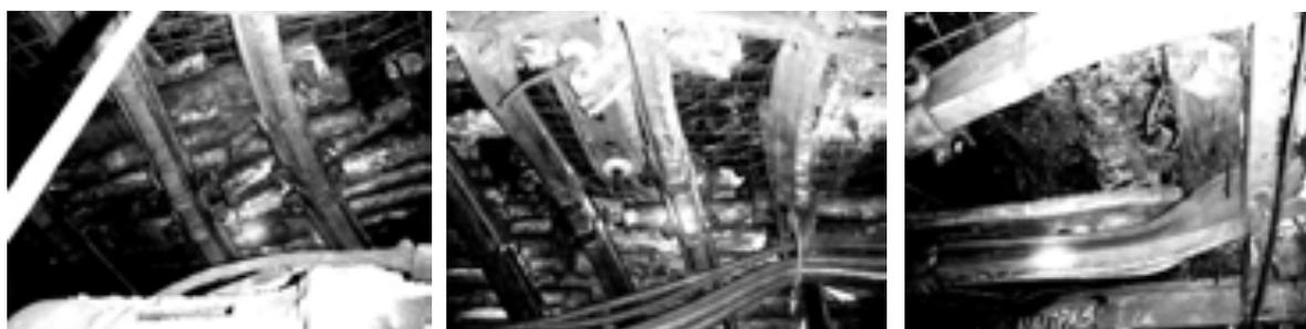
Рис. 4. Деформации верхняков рамной крепи КМП разрывы сплошности, потери продольной устойчивости и скручивания профиля
